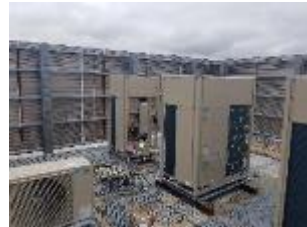
某銀行 空調設備更新工事
