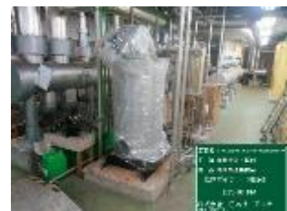
県立美術館 蒸気ボイラー据付工事
