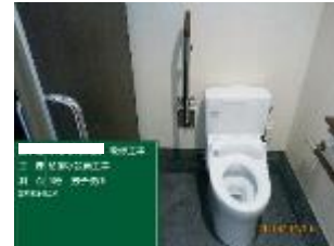
A病院給排水設備工事
