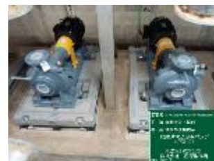
県立美術館 ポンプ据付工事
